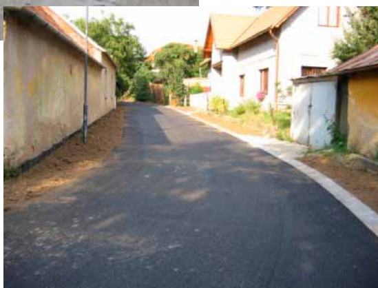
výjezd z obce (AVZO) po rekonstrukci
