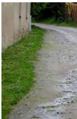
výjezd z obce (AVZO) před rekonstrukcí
